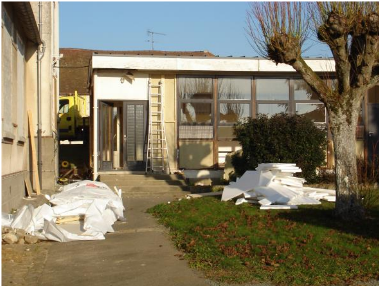
Ancienne classe en préfabriqué construite avant 2008
