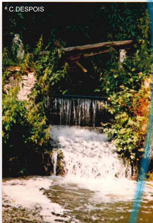
L'écluse du Moulin d'Andret
